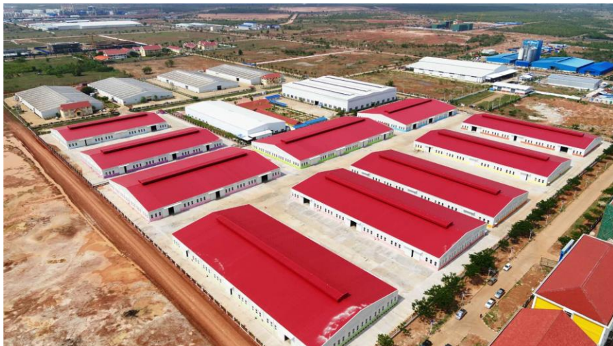
赛色塔综合开发区
