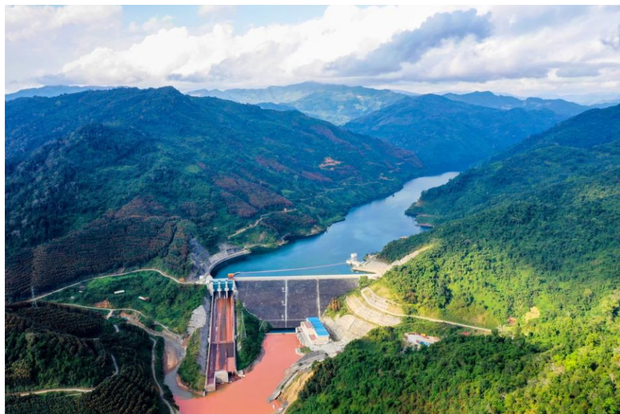
南欧江六级水电站
